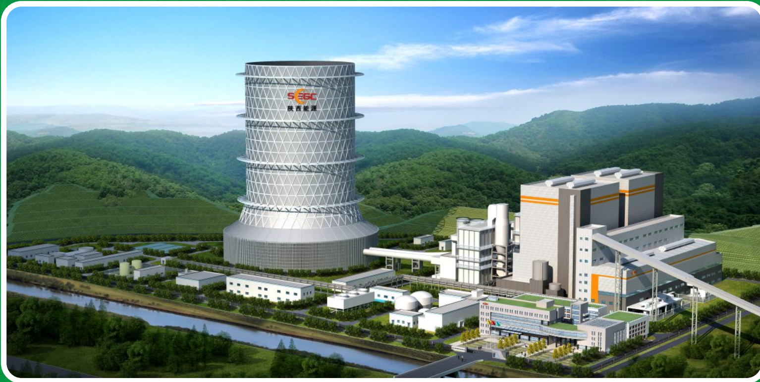
陕能麟游循环流化床机组脱硫、脱硝、除尘一体化项目
