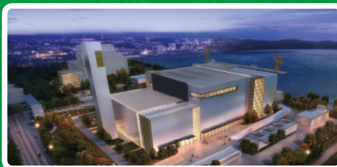
常熟浦发垃圾焚烧余热锅炉项目
